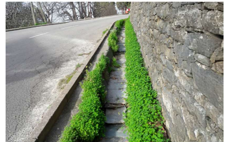
Conduire l'eau (Oletta)
