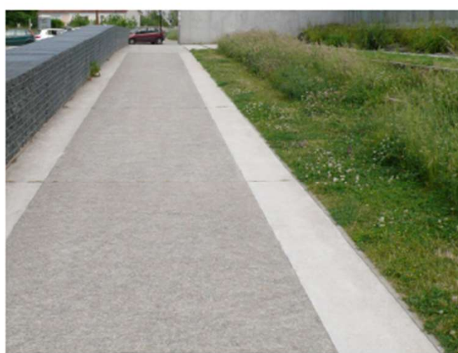
Béton coulé désactivé, rives lisses, Nantes - Bruel Delmar
