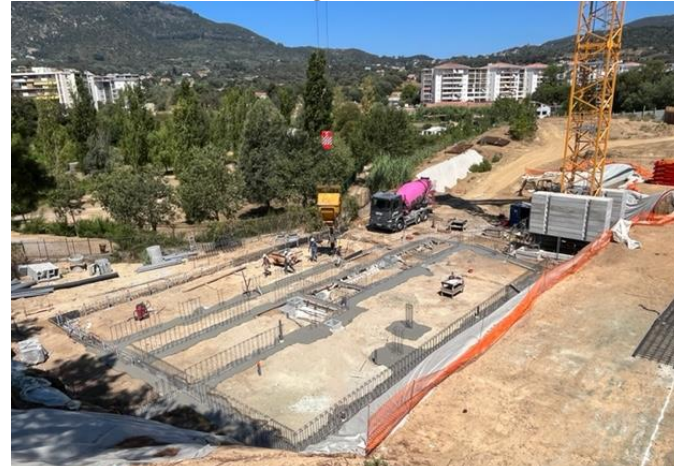
Fondations en cours partie Sud -> 03/08/2022
