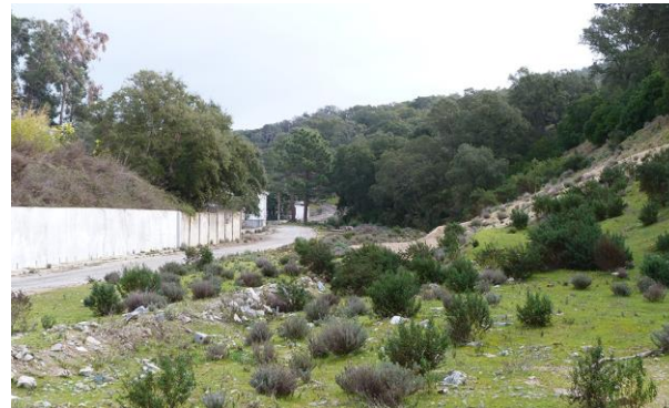
Janvier 2021, avant les travaux de terrassement, démolition, débroussaillage
