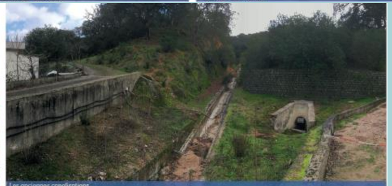
Les anciennes canalisations
