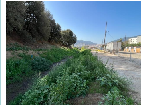
Octobre 2022 finition des travaux de terrassement
